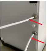
7. Lắp ống nhựa PE từ van cấp nước đến ngõ vào nước trên máy, rồi lắp thêm ống cho ngõ xả nước..
