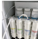
19. Gắn ống nhựa PE từ bước 18 gắn đến ngõ vào của bộ lọc Maifan.
