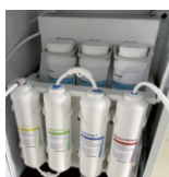
20. Gắn thêm 1 đoạn ống nhựa PE vào ngõ ra của bộ lọc Nano Silver-T33 để nước chảy ra ngoài.
