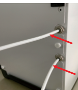
7. Lắp ống nhựa PE từ van cấp nước đến ngõ vào nước trên máy, rồi lắp thêm ống cho ngõ xả nước.
