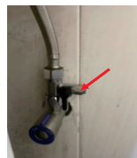
4. Lắp van cấp nước vào đường ống nước máy.
